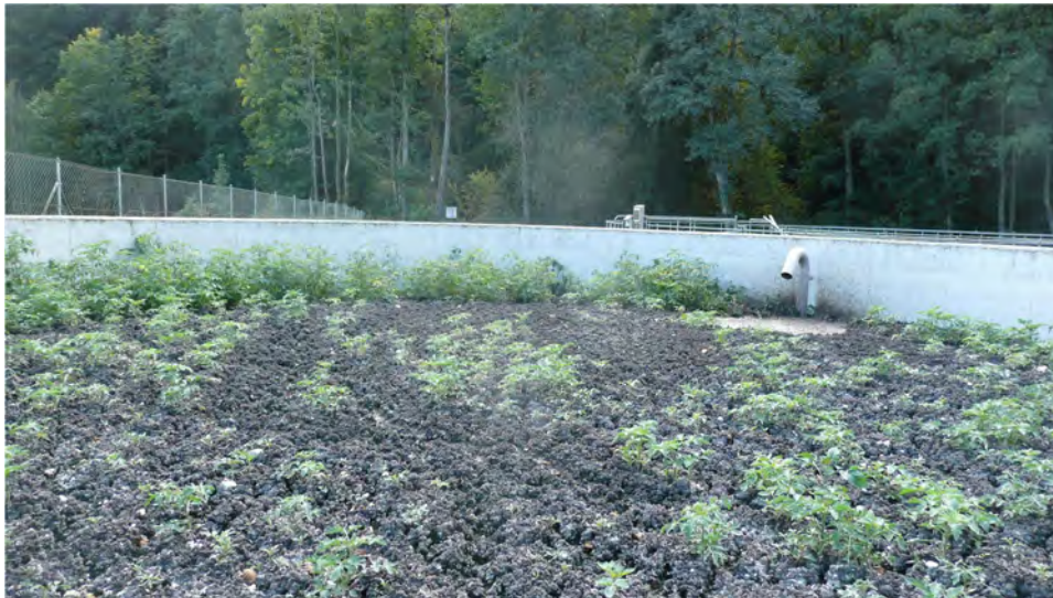
Abbildung 54: Schlammstapelbehälter der Kläranlage SN mit Tomatenpflanzen auf der Schwimmdecke, am 29.09.2015
