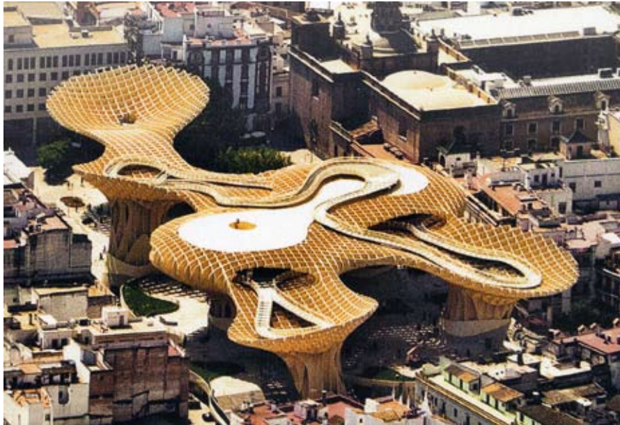
Abb. 1: Trägerrost-Konstruktion zur Beschattung des historischen Marktplatzes von Sevilla (Foto: J. Mayer H.).
