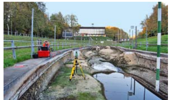
Abb. 3: Laserscanner im Einsatz.
