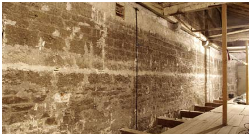
Abb. 5: Salzburg, St. Peter, südlicher Obergaden von Westen.
