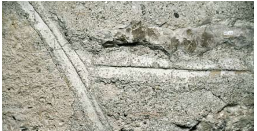
Abb. 4: Salzburg, St. Peter, nördlicher Obergaden, Fugen von Bau II.
