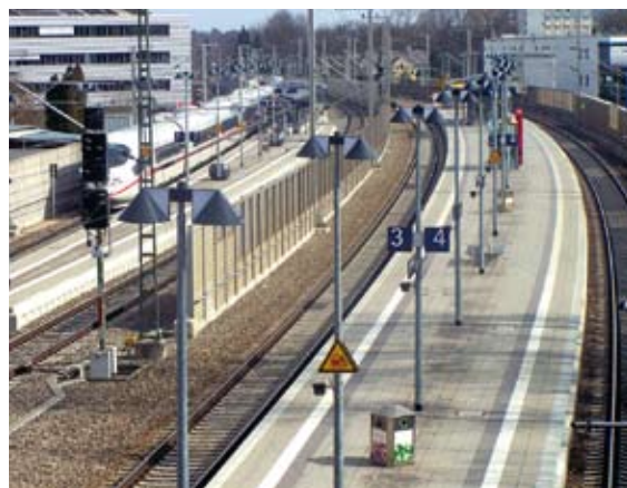
Abb. 1: Lärmschutz-Maßnahmen an der Bahn-Ausbaustrecke München – Augsburg, rechts und links der Strecke und unter den Bahnsteigkanten Lärmschutzwände mit offenporigen Betonsteinen, in der Mitte transparente Lärmschutzwände, rechts gelochte Akustik-Absorberplatten. Bei Neu- und Ausbaustrecken in Stadtnähe verursachen Lärmschutzmaßnahmen erhebliche Kosten.
