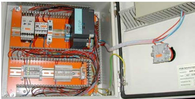
Abbildung 12: Ansteuereinheit für Greiftechnik.
