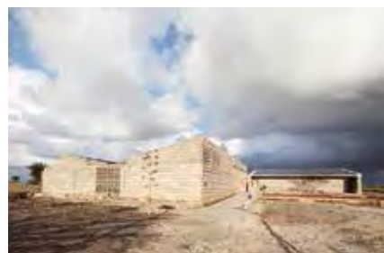
Handwerksschule Nairobi, errichtet als Design-Build-Projekt von Studierenden der HSA und der TU München.
