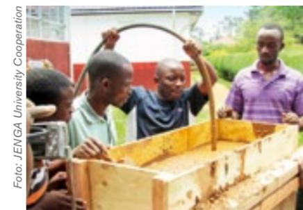
Bau von Prototypen für stabilisierte Lehmwände an der Uganda Martyr Universität.
