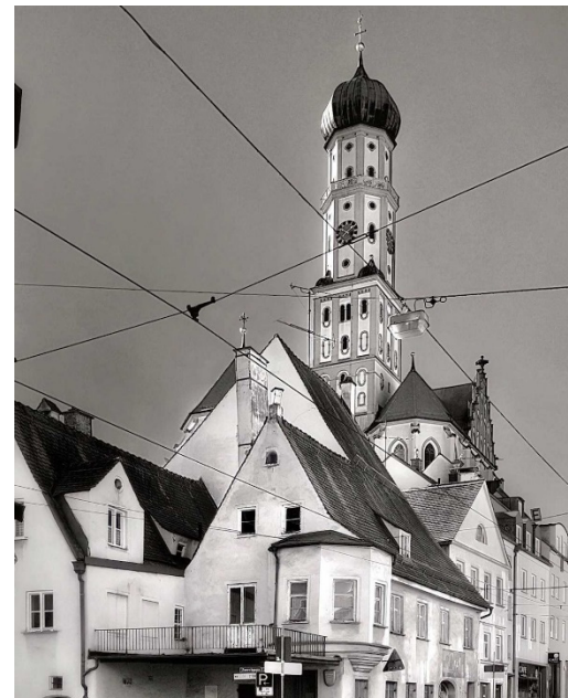
Die alte Schmiede, ein komplexes Gebäude mit viel Charme und Flächenpotenzial
