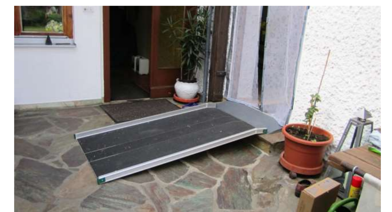
Provisorische Lösung: Rampe von außen (Bild: Simon Schönauer)
