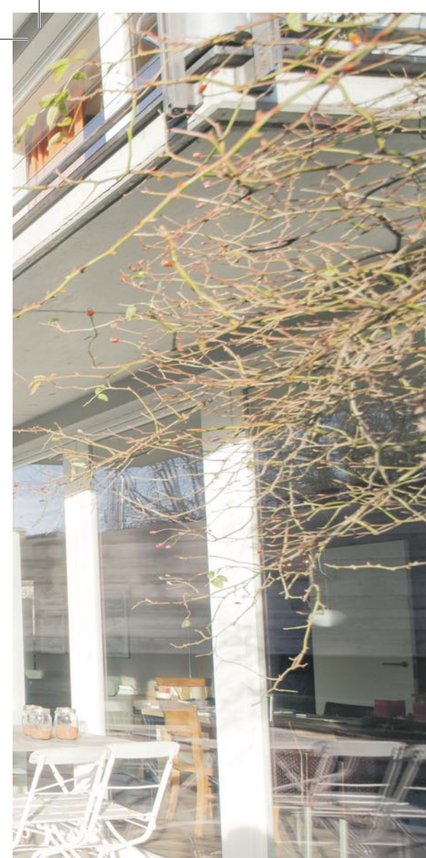
Puristisch gehaltener Anbau an das bestehende Wohnhaus der Familie. The extension to the existing family home is pure and minimal in style
