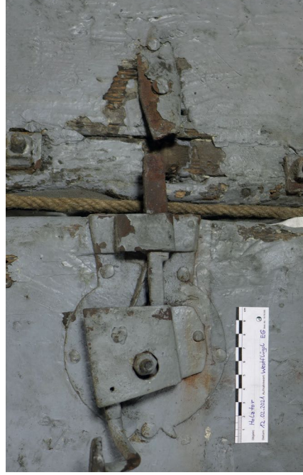
Abb.: 13 Schloss mit abgebrochenem Heberriegel
