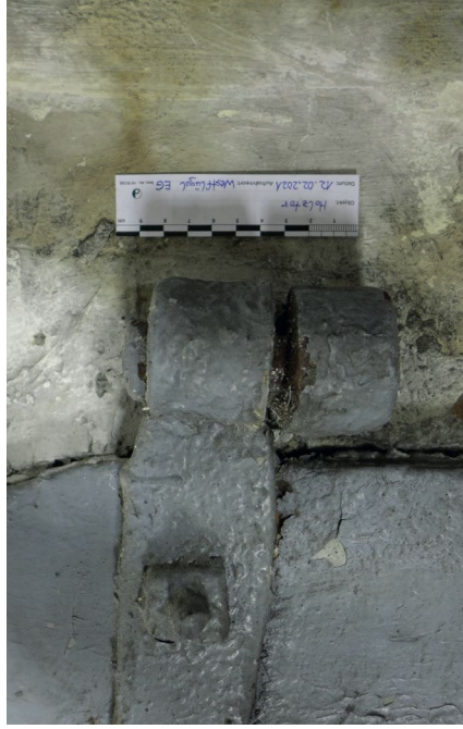
Abb.: 8 Türscharnier rechts oben
