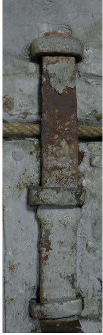
Abb.: 11 & 12 Schubriegel der Schlupftür
