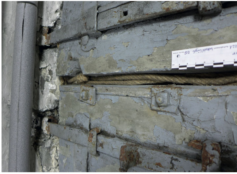
Abb.: 16 Verbogene Schubschlösser mit Klobe
