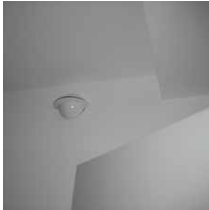
Abb. 80: Zuluftelement
