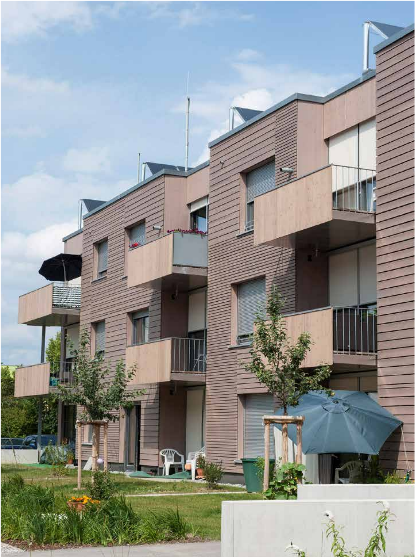
Abb. 84: West-Fassade mit privaten Freiflächen, Balkonen und der solarthermischen Anlage auf dem Dach
