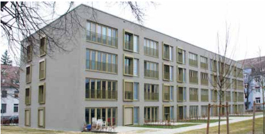
Abb. 133: Süd-West-Ansicht des Gebäudes
