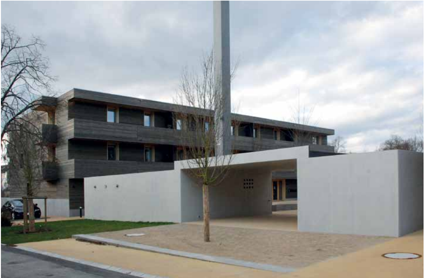
Abb. 57: Blick von der Straße auf die Heizzentrale
