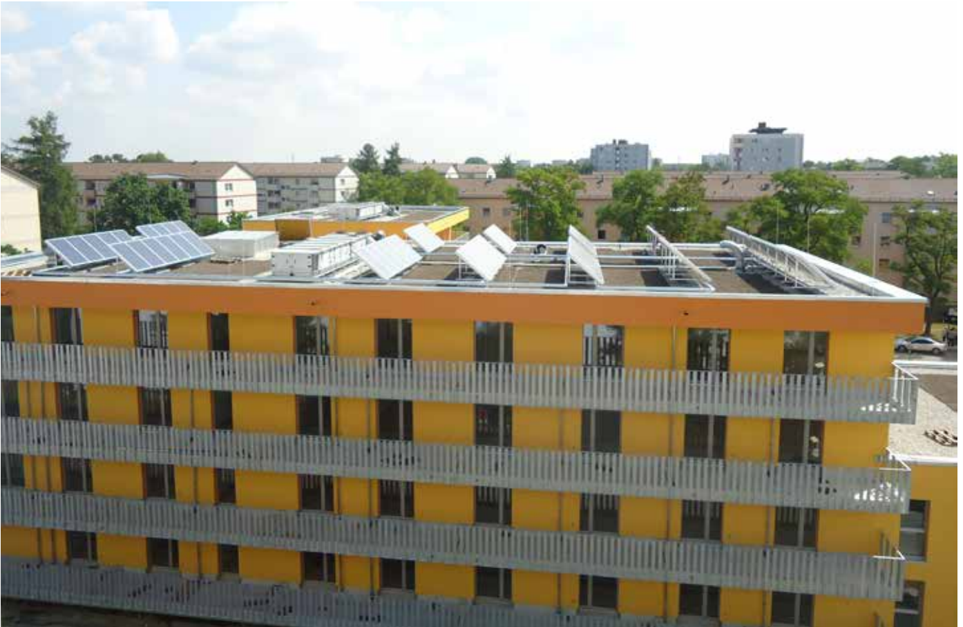
Abb. 124: Technikkomponenten auf dem Dach
