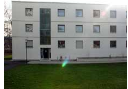
Abb. 44: Foto: Dreigeschossiger Baukörper
