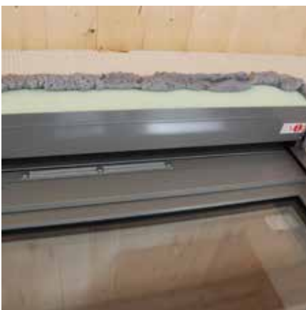
Abb. 42: Fenster mit Überströmöffnung kurz nach dem Einbau
