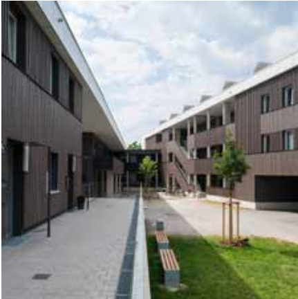
Abb. 154: Ost-West-Orientierung in Ingolstadt Bauteil 1
