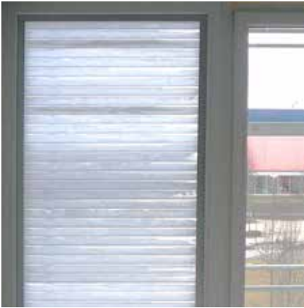
Abb. 138: Innenansicht eines Fensters mit GlassX-Element
