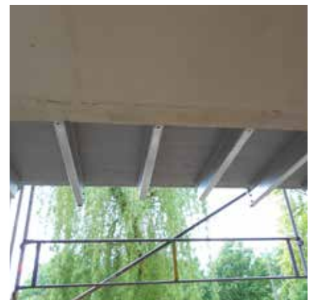
Abb. 17: Verbreiterung der Balkone
