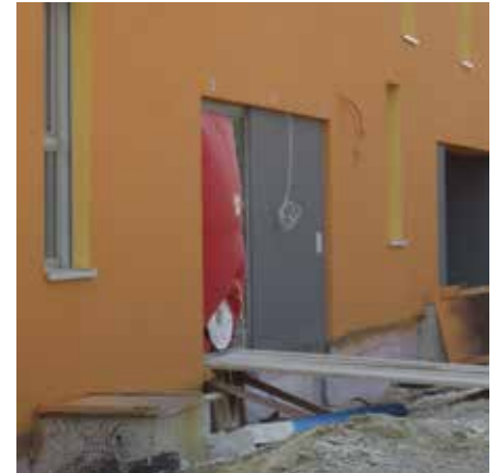
Abb. 170: Luftdichtigkeitsmessung während der Bauphase in München
