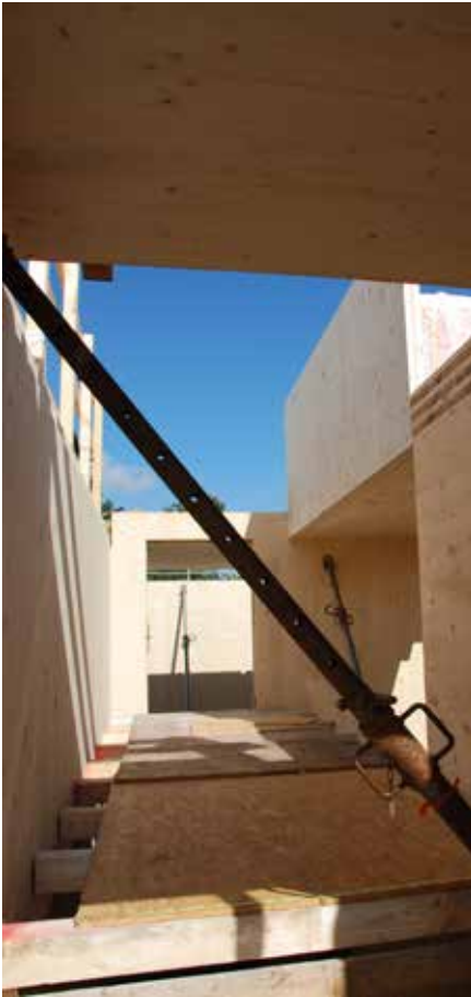
Abb. 60: Aufbau der Gebäudewände
