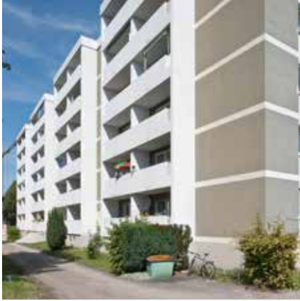
Abb. 156: Das Projekt in Augsburg vor der Sanierung
