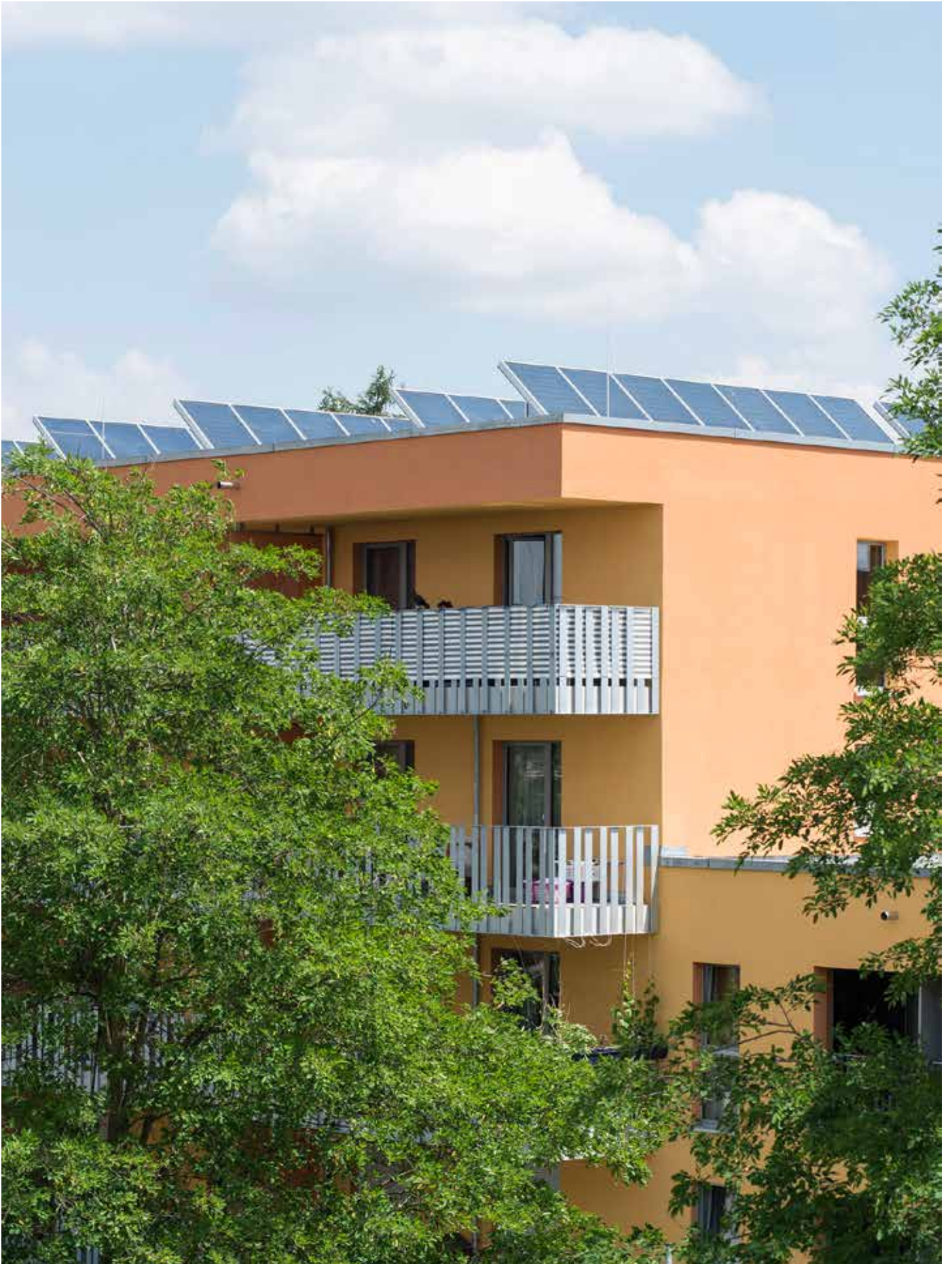
Abb. 111: Viergeschossiger Baukörper mit solarthermischer Anlage und Zwischenbaukörper
