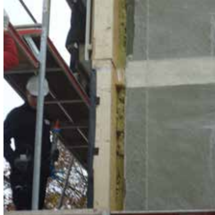
Abb. 36: Hinterfüllung der neuen vorgesetzten Fassade
