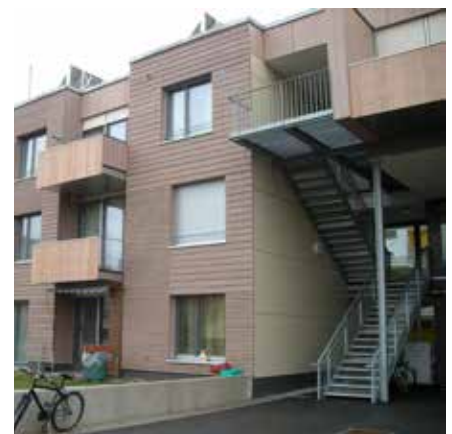
Abb. 91: Außenansicht von Osten
