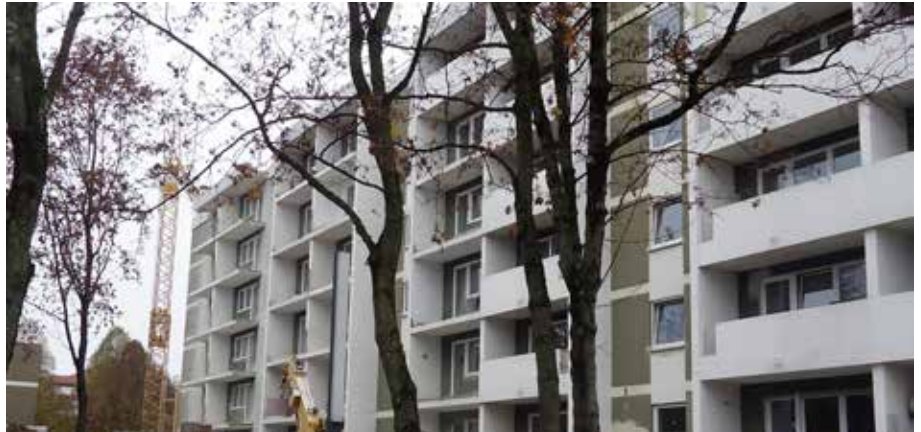
Abb. 34: Fassade kurz nach Beginn der Sanierungsmaßnahmen
