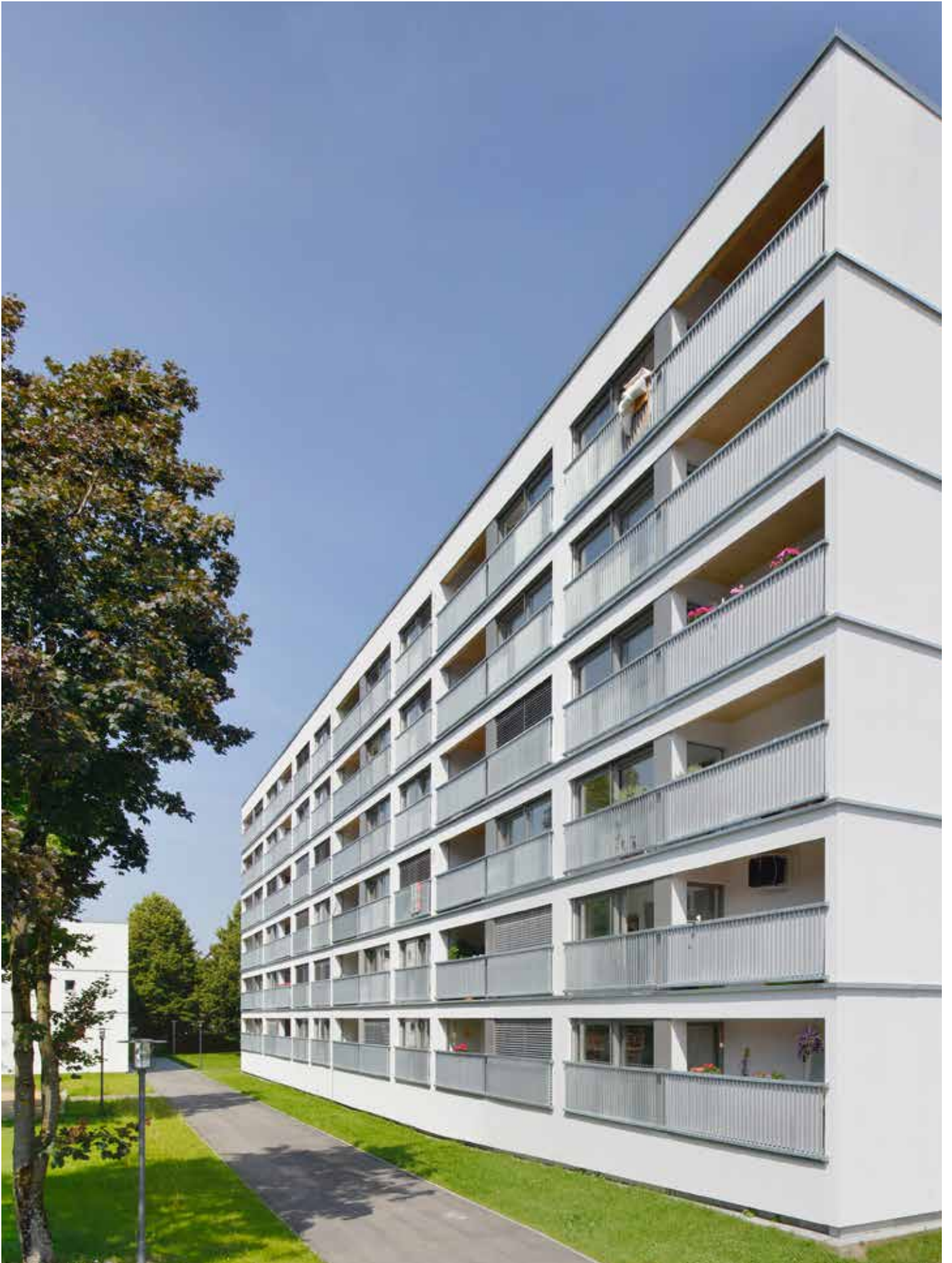
Abb. 27: Süd-Fassade mit Loggien
