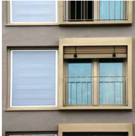
Abb. 166: GlassX-Element mit Latentwärmespeicher in Neu-Ulm
