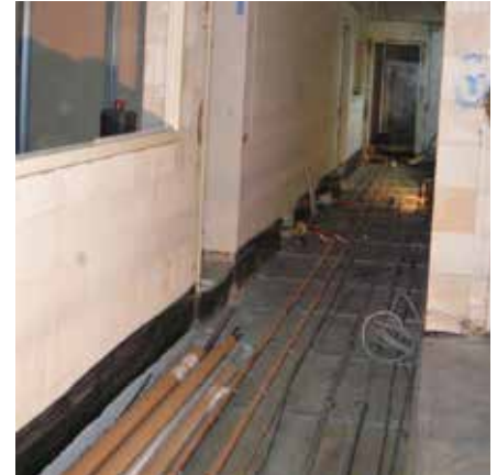
Abb. 143: Leitungsverteilung in der Erdgeschossdecke
