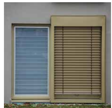
Abb. 137: Außenansicht Fenster mit GlassX - Element bzw. außenliegendem Sonnenschutz
