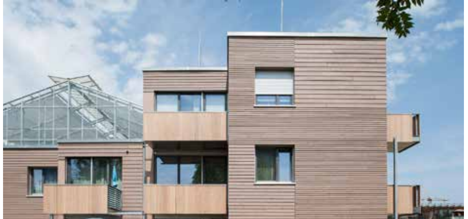
Abb. 155: Atriumsbau in Ingolstadt Bauteil 2
