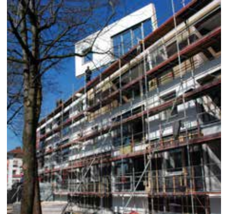
Abb. 37: Einbau der Fassadenelemente
