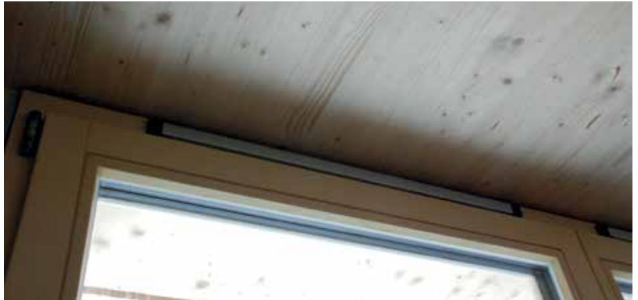
Abb. 61: Fenster mit Überströmöffnung
