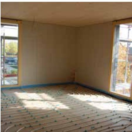
Abb. 63: Verlegte Schläuche für die Fußbodenheizung
