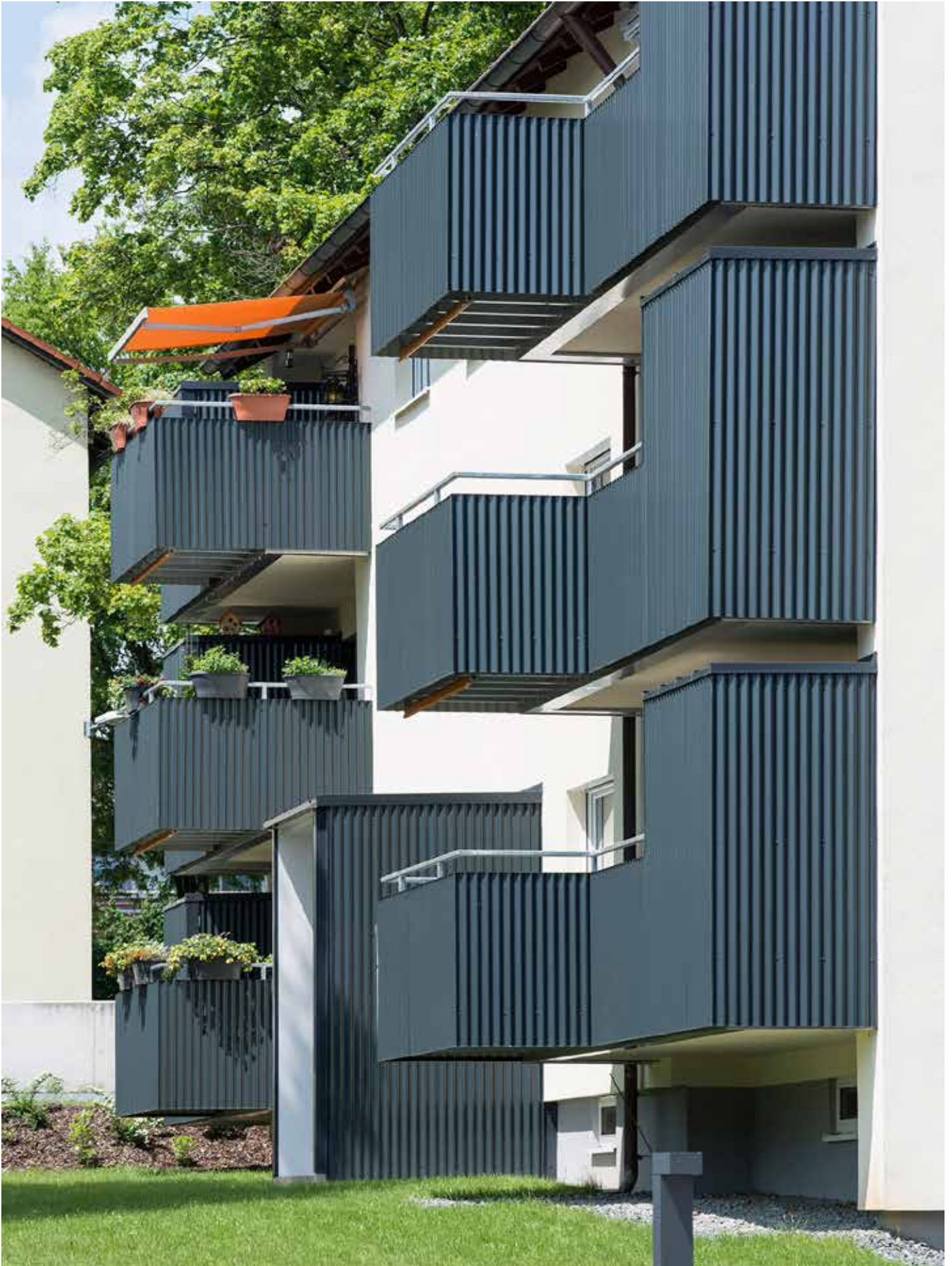
Abb. 9: Süd-West-Seite mit Balkonen und Eingangsbereich
