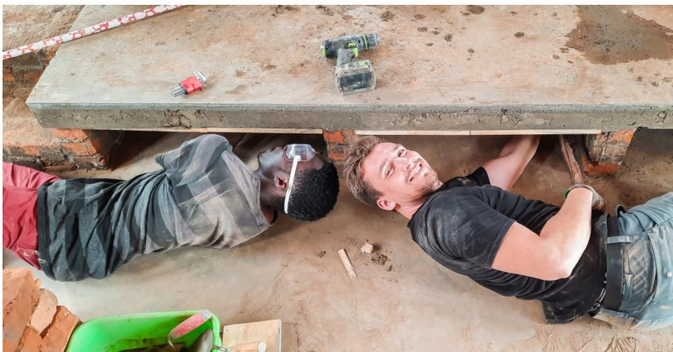
Aufgrund des örtlichen Umgangs mit Wasser zur Bodenreinigung wurde auch die Planung der Sitzstufen und der Treppe angepasst. Die Abstufungen wurden ebenfalls gemauert und anschließend betoniert.
