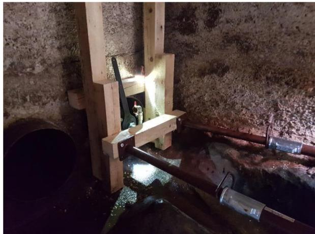
Abbildung 67: Einbausituation des Absperrorgans am Leitungsende Zirndorf
