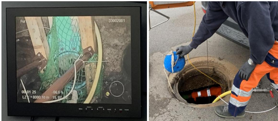
Abbildung 76: Installiertes Fangnetz am Leitungsende und Entnahme des gepolsterten Smart-Balls nach der Untersuchung in Zirndorf
