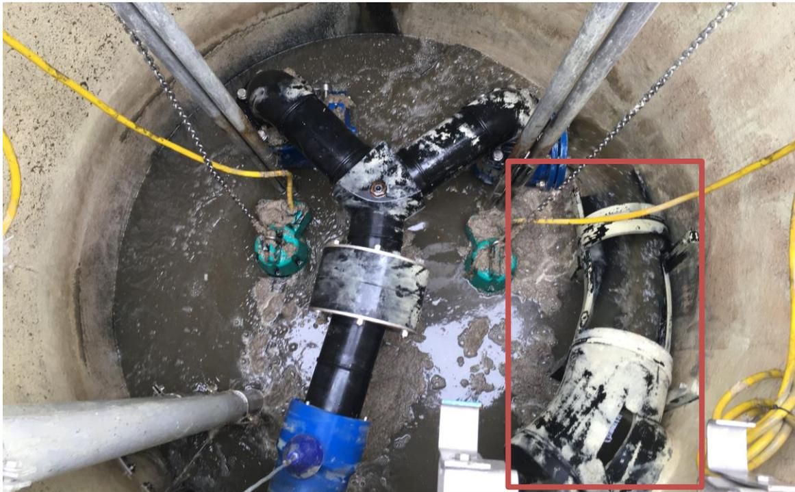
Abbildung 69: Rutschsystem zur Vermeidung des ungewollten Lufteintrags in Druckleitungen (Hamburg Wasser)
