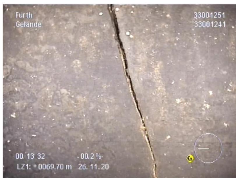
Abbildung 79: Detailliertes Schadensbild des klaffendes Risses mit einer Breite von 4 mm der südlichen Druckleitung Zirndorf, Kamerabefahrung am 26.11.2020 (Stadtentwässerung Fürth)
