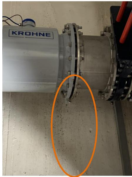
Abbildung 73: Undichter MID in Ludwigsburg
