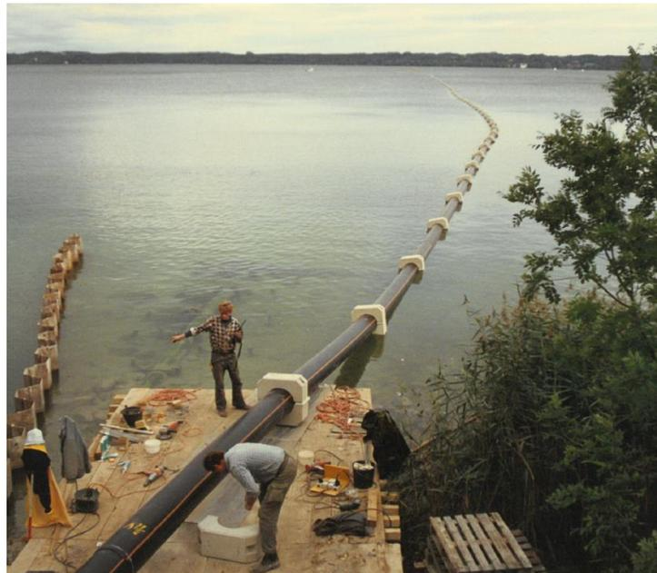
Abbildung 81: Anbringen der Betongewichte und anschließende treibende Lagerung am Starnberger See (AV Starnberger See)
