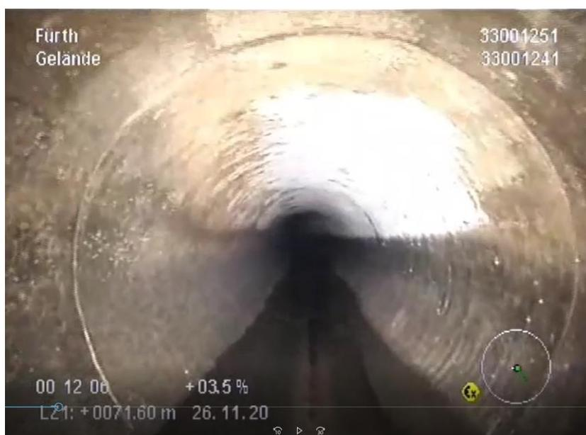
Abbildung 78: Ausschnitt aus der Dokumentation der Kamerabefahrung mit radialem, klaffenden Riss um den kompletten Umfang der Druckleitung, Kamerabefahrung am 26.11.2020 (Stadtentwässerung Fürth)
