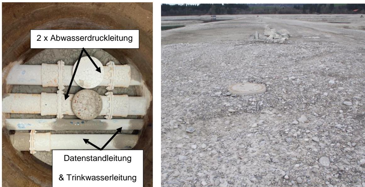
Abbildung 95: links: Innenansicht des Schachts auf dem Seegrund des Forggensees; rechts: Ansicht des Schachtdeckels auf dem Kiesdamm am Seegrund, Blickrichtung Nord-Westen
