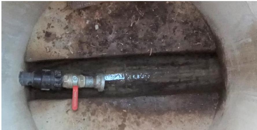
Abbildung 65: Anschluss eines Kugelhahns mittels Plasson
