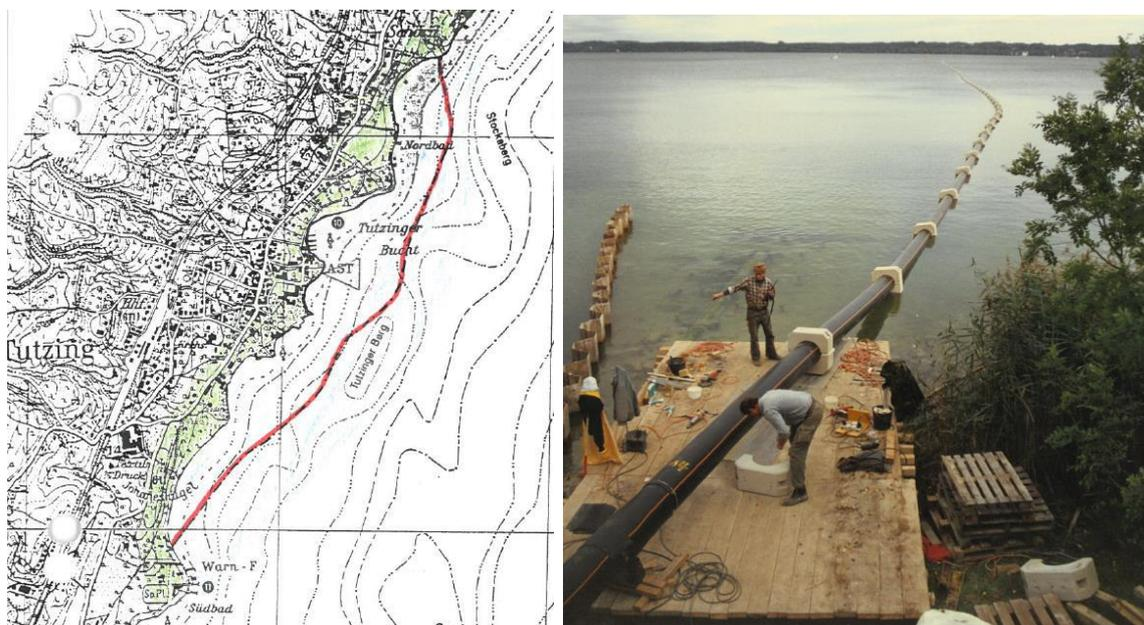
Abbildung 84: links: Lageplan der Seedruckleitung im Starnberger See; rechts: Fotodokumentation der Verlegung der Seedruckleitung im Starnberger See (AV Starnberger See)
