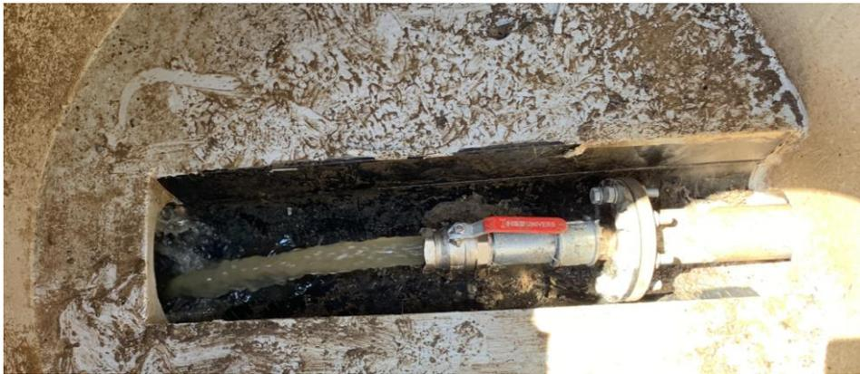
Abbildung 64: Anschluss eines Kugelhahns mittels Flansch
