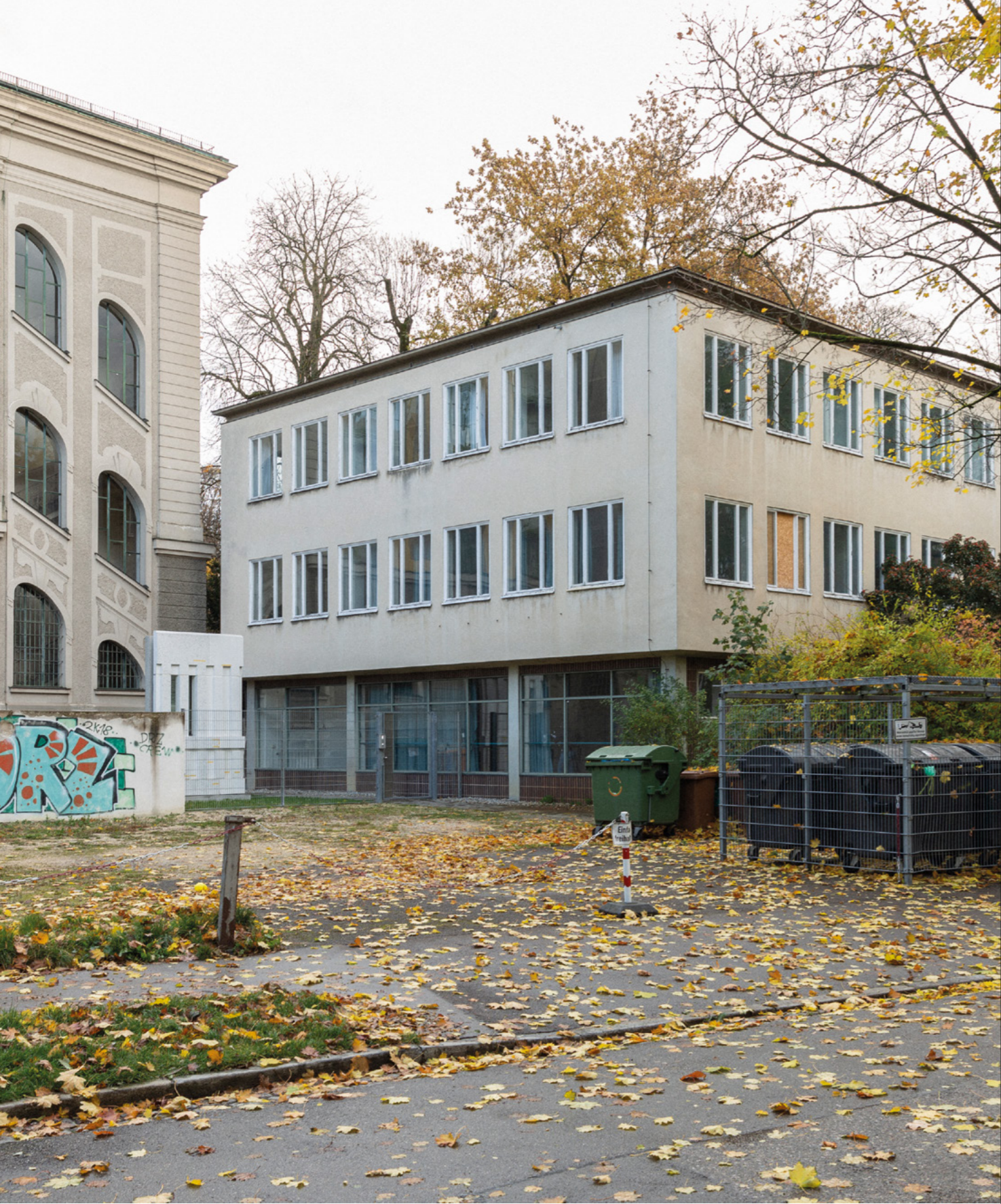
Die Alte Stadtbücherei Augsburg wurde im November und Dezember 2022 abgerissen. Durch das Transferprojekt „Architektur. Im Kreis.“ konnten 288 Bauteile wiederverwendet werden und ca. 18 Tonnen CO 2 eingespart werden.
