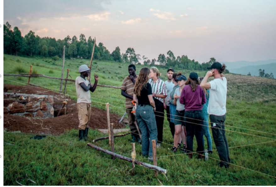
Vermessen und Abstecken der Gebäudeaußenkanten Measuring and defining the outer edges of the building
