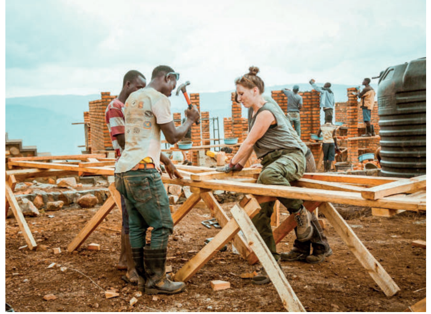
Dachbinder konstruieren Construct roof truss
