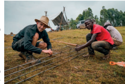
Binden der Bewehrungsseisen für den Ringanker Tying the armouring irons for the ring beam
