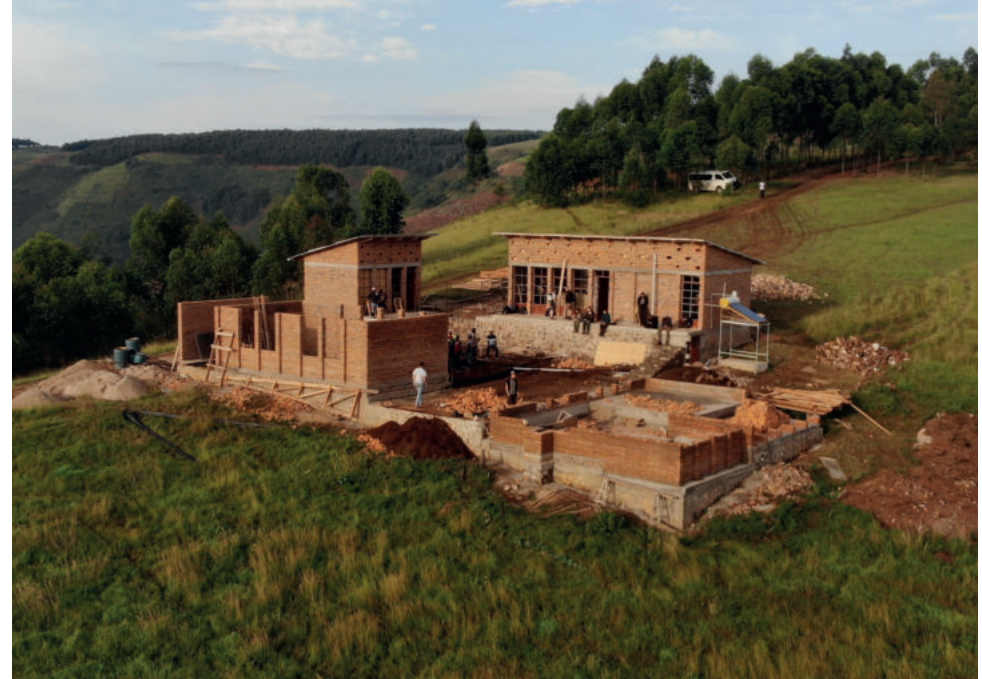
Rohbauarbeiten an dem Lern- und Wohncluster Structural work at the learning and living cluster
