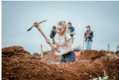
Ausheben der Fundamente Digging the foundations
