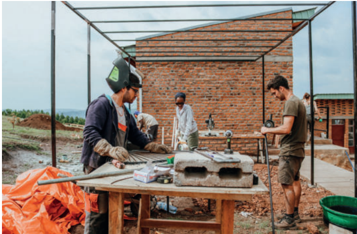
Strahlarbeiten für die Pergolen Steelwork for the pergolas
