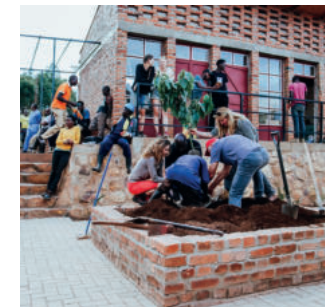
3. Baustellenphase im Februar/ März mit Studierenden der TU München, der Hochschule Augsburg und der Martyrs University, Uganda, Innenausbau und Außenraumgestaltung
