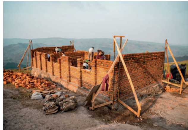
Mauerarbeiten am Küchenhaus Brickwork at the kitchen house
