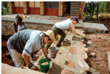
Bodenbelag „Dorfplatz“ „Village square“ flooring
