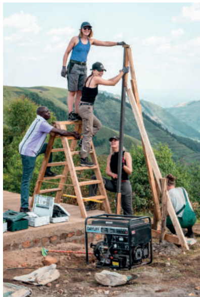
Schmugerüst für die Mauerarbeiten Scaffolding for the brickwork
