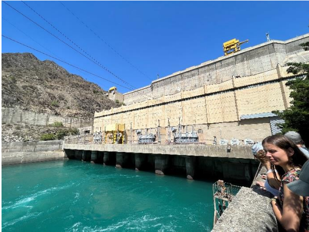
Das Kraftwerk „Kurp-Sai“
