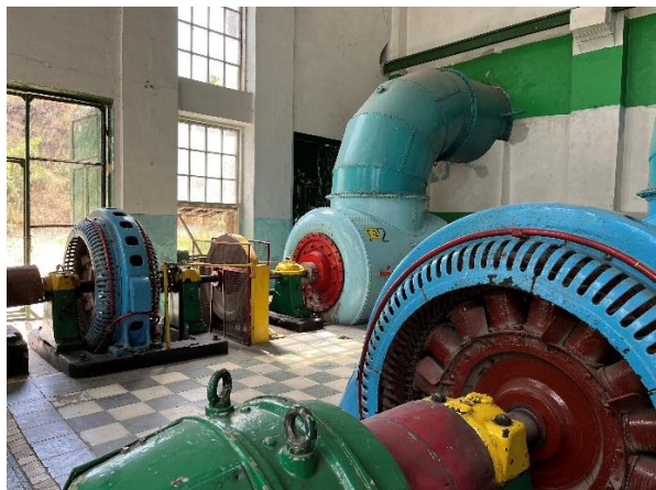
Kraftwerk aus dem Jahr 1910
