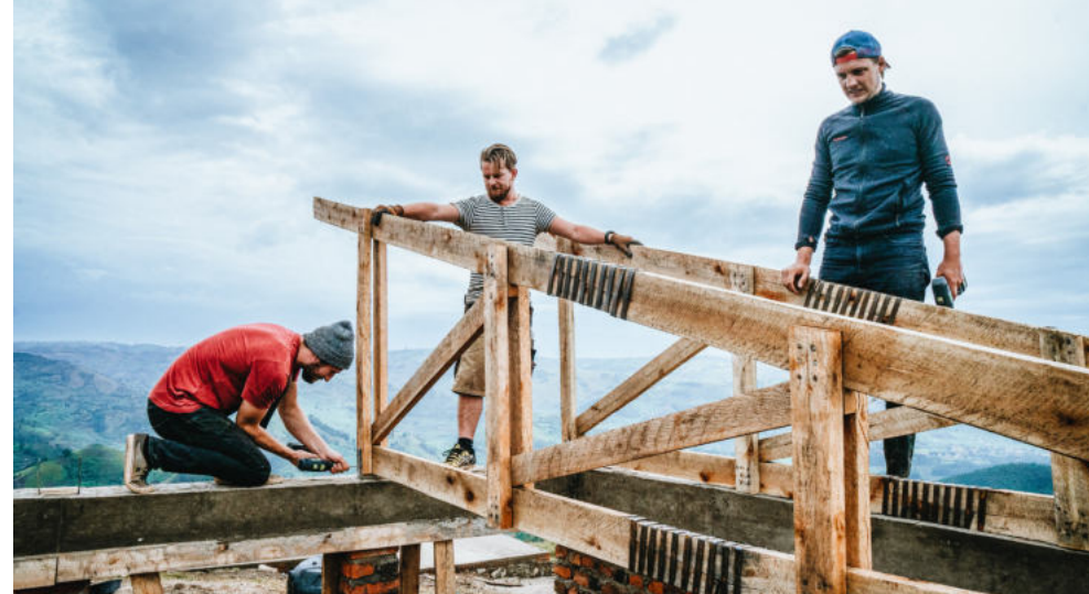
Befestigen der Dachbinder auf dem Rinanker Fixing the roof trusses to the ring beam
