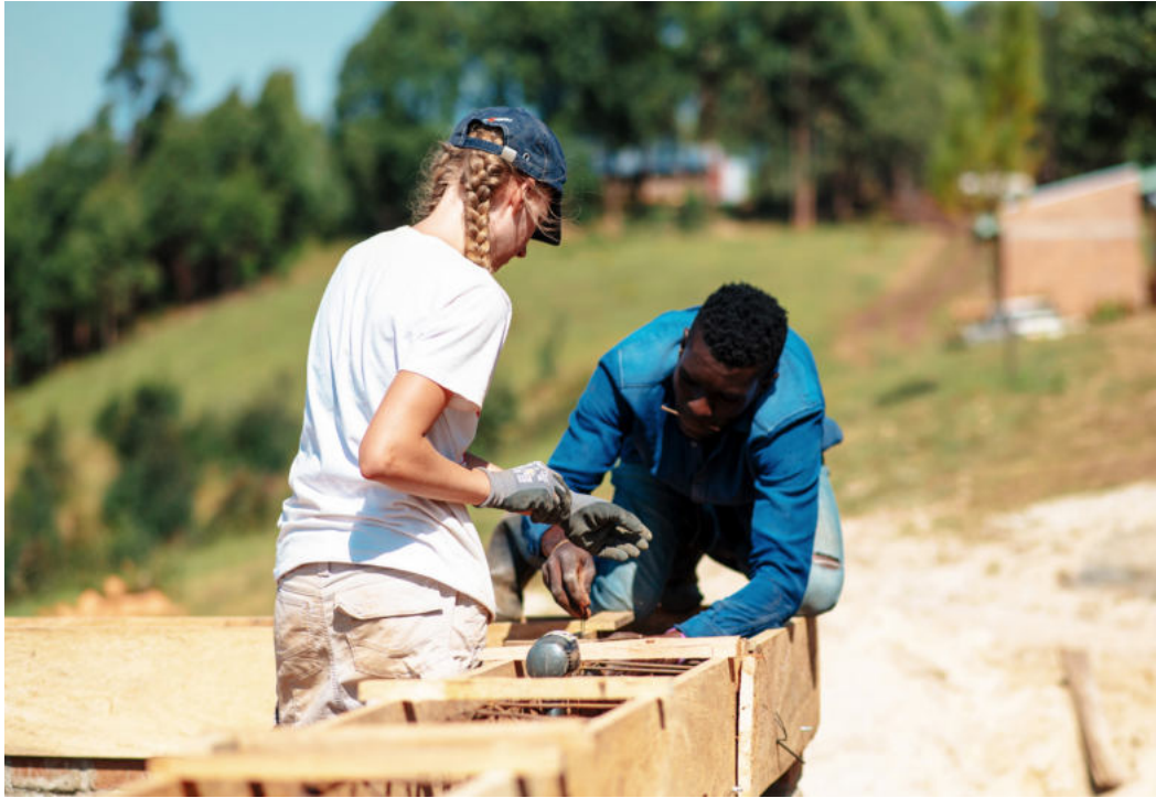
Erstellung des Unterzuges creation of the beam
