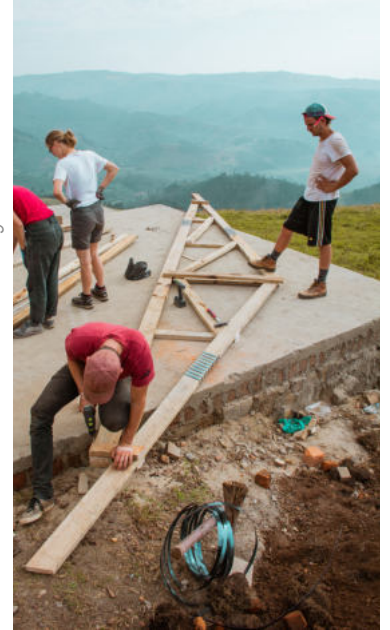
Konstruieren der Dachbinder Constructing the roof trusses
