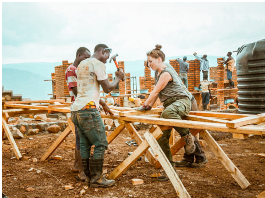
Dachbinder konstruieren Construct roof truss
