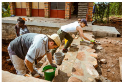
Bodenbelag „Dorfplatz“ „Village square“ flooring
