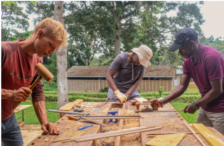
Herstellen der Holzdübel making the wood dowels
