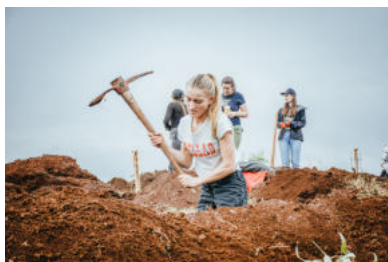
Ausheben der Fundamente Digging the foundations
