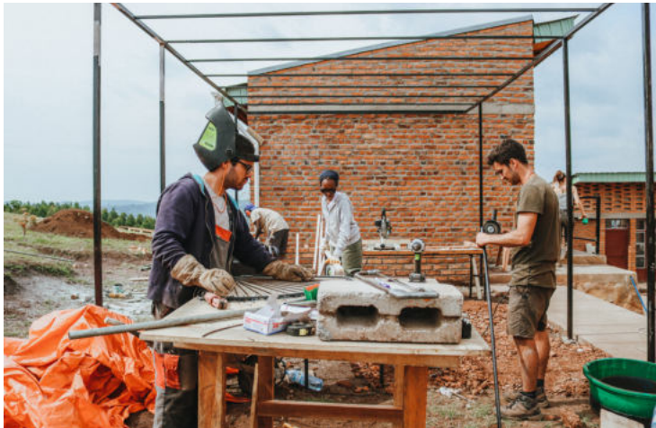
Stahlarbeiten für die Pergolen steelwork for the pergolas
