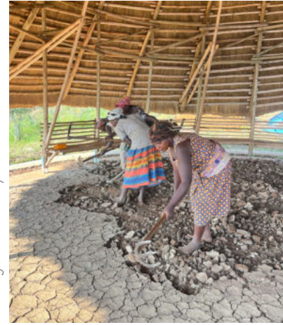
Abtragen der rissigen Schicht removing the cracked layer
