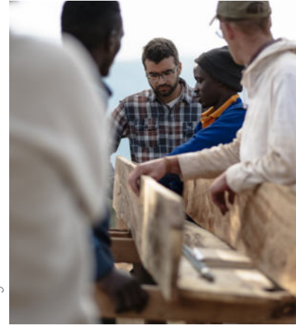
Schalungsetzen setting the formwork
