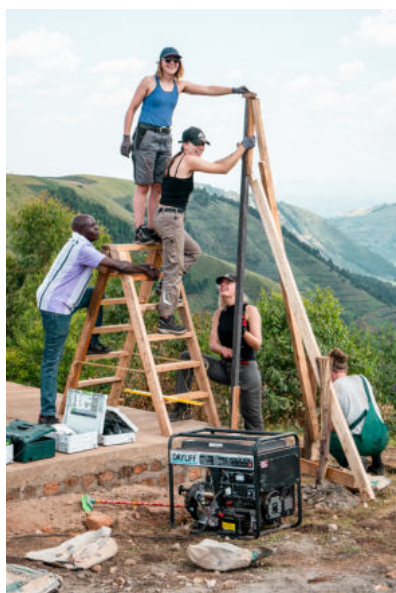
Schnurgerüst für die Mauerarbeiten Scaffolding for the brickwork
