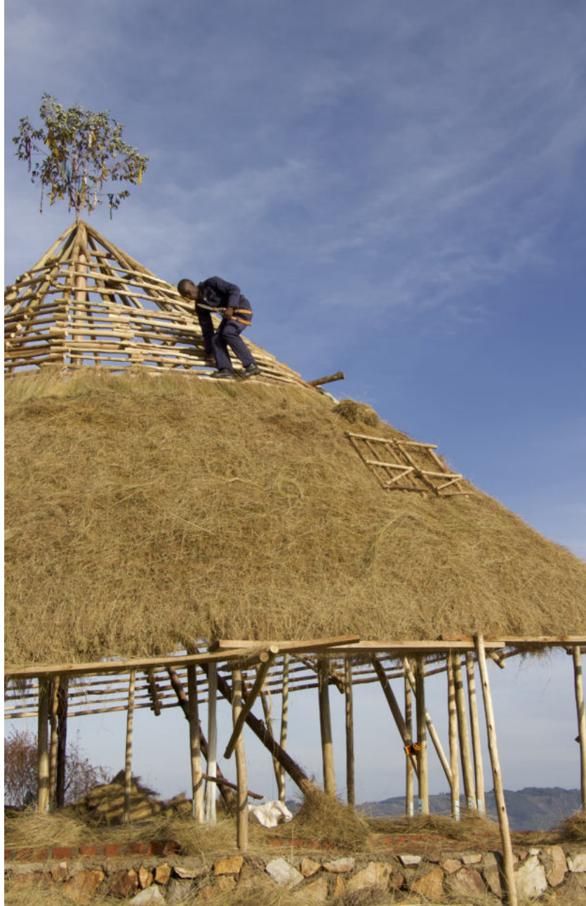
Dachdeckenarbeiten am Pavillon roofing work on the pavilion
