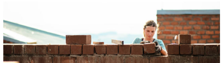
Maurerarbeiten masonry work
