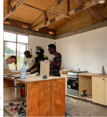
Schreinerarbeiten für die Küche carpentry work for the kitchen
