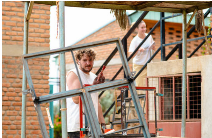
Malararbeiten painting work
