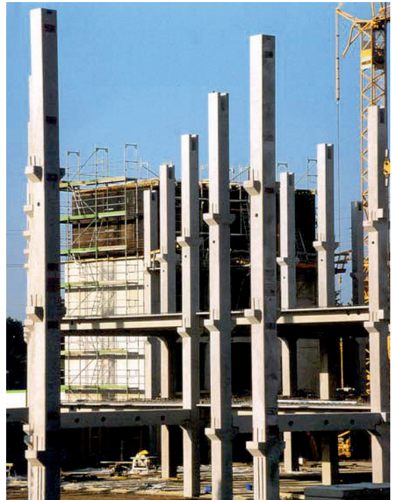
Bild 1: Fertigteilkonstruktion mit Konsolen
