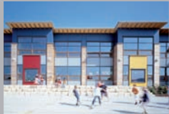
Passivhaus Schule Roodt/Luxemburg
