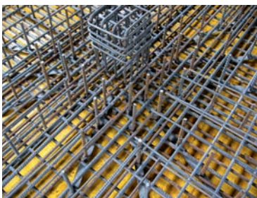
Bild 4: Durchstanzblechleisten mit HFV-Ankern
