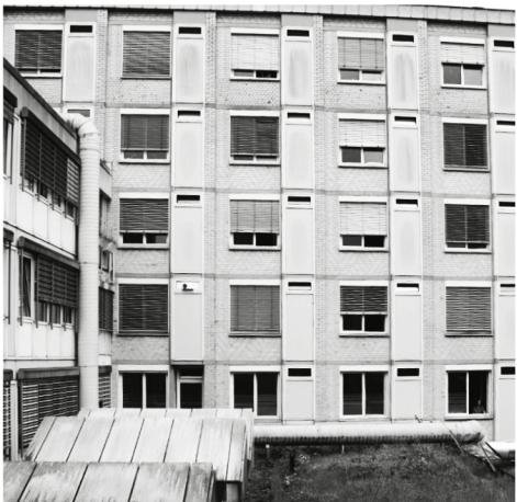
// fassade bestand bauteil von 1955 | ursprungsbaukörper
