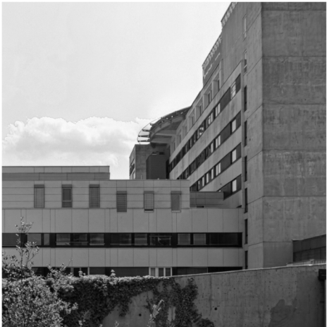
// vorher: unzugänglicher werkhof
