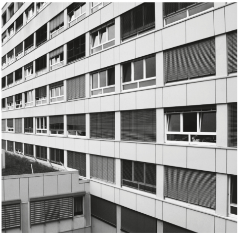
// facade bestand bauteil von 1970
