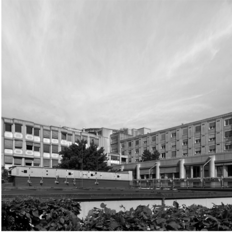
// vorher: mit interimcontainer verbauter außenraum
