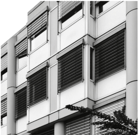
// fassade bestand, erker und teils außenliegende stützen
