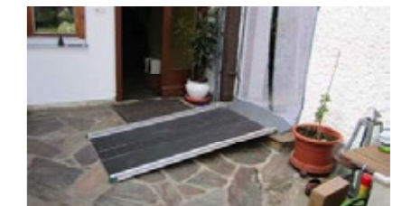
Provisorische Lösung: Rampe von außen (Bild: Simon Schönauer)
