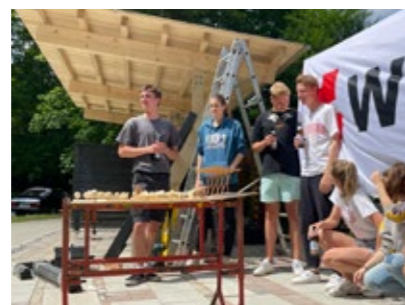
Bauteam mit Entwurfsmodell vor dem fertigen Dach, Quelle: HSA_transfer
